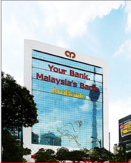
Bangunan AmBank Group
