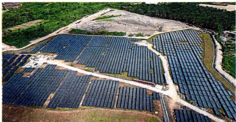
TAMAN solar 8 megawatt milik Cypark di Pajam, Negeri Sembilan.
