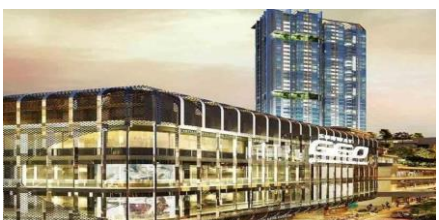
Sunway Geo Suites
